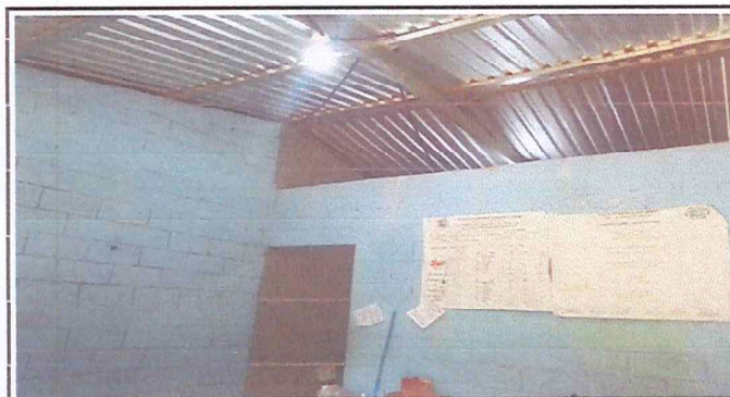
Foto 4: Se observa el interior de la Dirección del establecimiento con una nueva estructura de techo.(19-11-2024).
