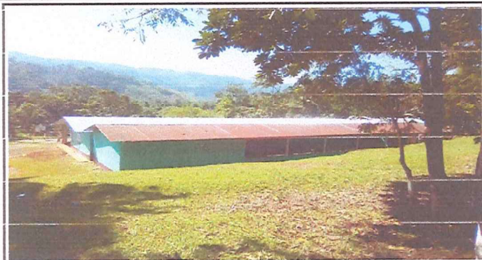
Foto1: Se observa la nueva cubierta de techo de 4 aulas, y dirección. (14-11-2024).
