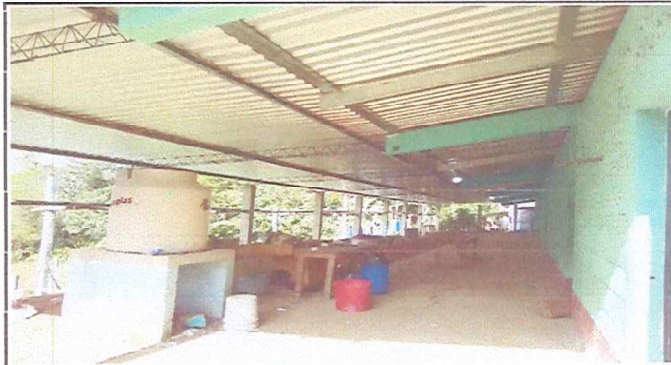
Foto 2: Se observa el cambio con nueva estructura de techo del corredor de cuatro aulas y dirección. (16-11-2024).
